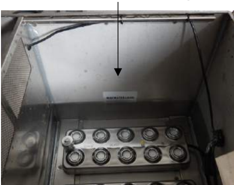
livello di carico acqua
